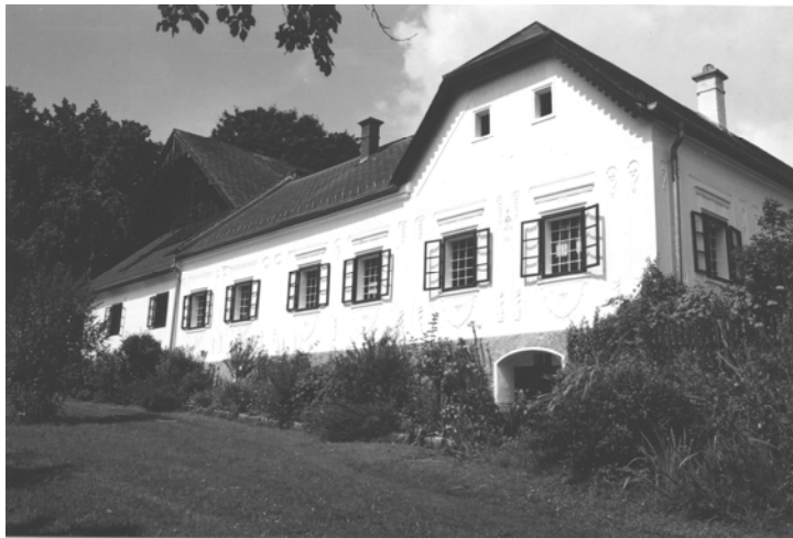
Bauernhaus in Hochart Nr.27. Dieser mächtige, 1813 erbaute Hof ist in mehreren Baustadien entstanden. Er zeigt eindrucksvoll die gesellschaftliche Stellung des Bauherrn. Die reich verzierte Putzschnitffassade ist vermutlich 1819 entstanden - eine Dreifaltigkeitsdarstellung in Seccomalerei im Bereich der Giebelfassade ist mit 1826 datiert. Im Giebelfeld selbst ist eine Datierung in römischen Ziffern von 1841 und die Initialen + M . E. + erkennbar (Foto:Komzak)
