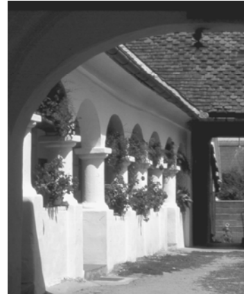
Bauernhaus in Jabing, 6-achsiger Arkadengang. Volle, runde Korbbögen und kurze, dicke Säulentrommeln weisen auf eine Bauzeit um 1820 hin. (Foto: Komzak)
