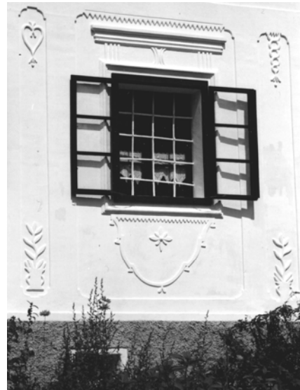
Bauernhaus in Hochart Nr.27. Detail der Putzschnittfassade. Zahnschnitt, Sechsstern und Lebensbaum finden sich ebenso wie die neuen josefinischen Stilelemente von Zopf und Gehänge. Die Fensterüberdachung wird von stilisierten Kragel-elementen des Barock getragen. (Foto: Komzak)
