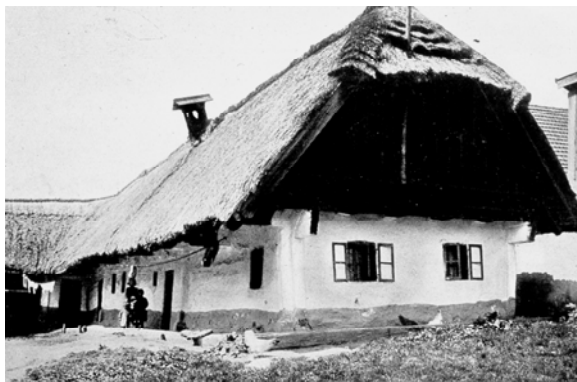
Bauernhaus in Oberwart Nr. 303. So könnte das von Michael Polster im Jahr 1757 gebaute Bauernhaus ausgesehen haben. Deutlich sind die 4 Bretter für den Rauchabzug erkennbar (4)
