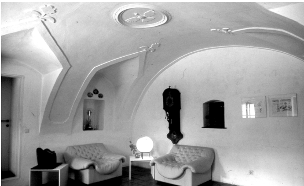
Hinterstube des Bauernhauses Aschau Nr.49, erbaut 1820. Tonnengewölbe mit Stichkappen, Gliederung und Auszier in Putzschnitttechnik. Die Heiliggeisttaube im Medaillon an der Decke und die Strahlenrosen am Ende der Stichkappen weisen auf eine Verwendung des Raumes als evangelischen Andachts- und Betraum hin. (Foto: Komzak)
