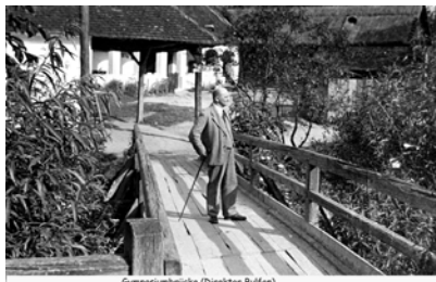
Gymnasiumsbrücke (Direktor Bullen)
