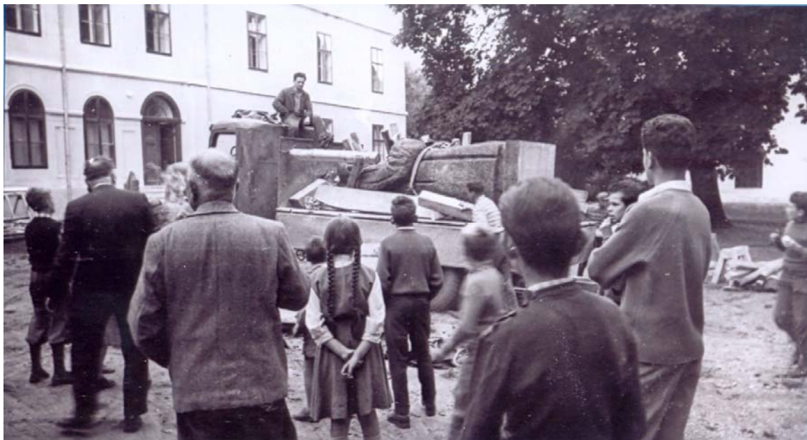
Anlieferung des Wimmer-Denkmal Oktober 1958
