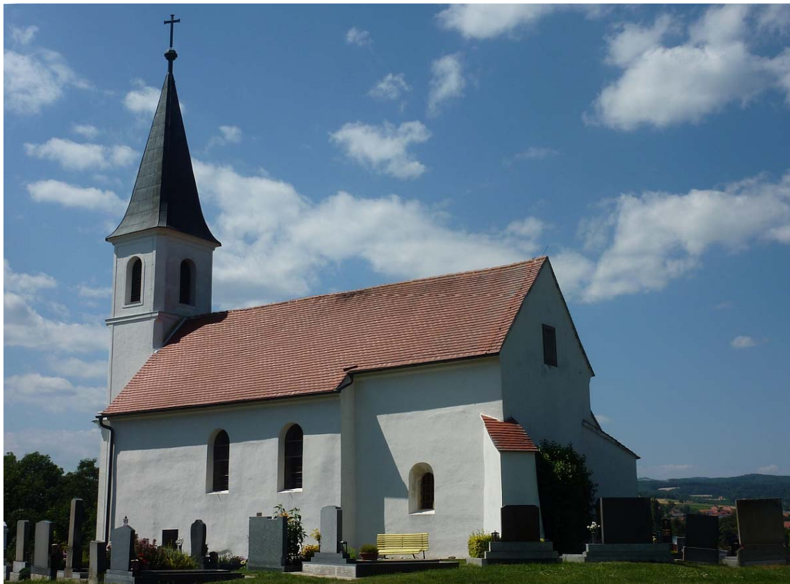
Abb.1 Oberschützen Bartholomäuskirche; Ansicht vom Südosten
